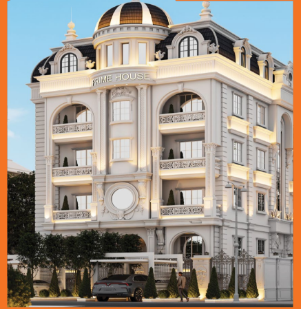
PRIME HOUSE الحي الثاني
