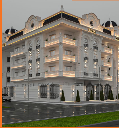
ALREHAB ICON شمال الرحاب القاهرة الجديدة
