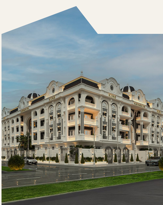
ALREHAB ICON شمال الرحاب القاهرة الجديدة
