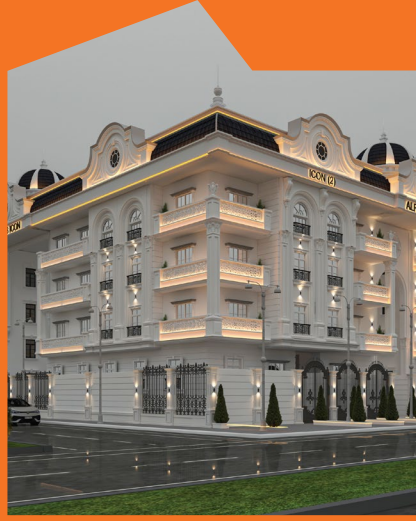
ALREHAB ICON شمال الرحاب القاهرة الجديدة
