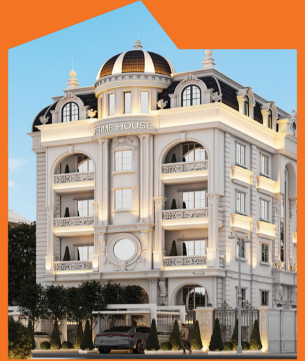
PRIME HOUSE الحي الثاني
