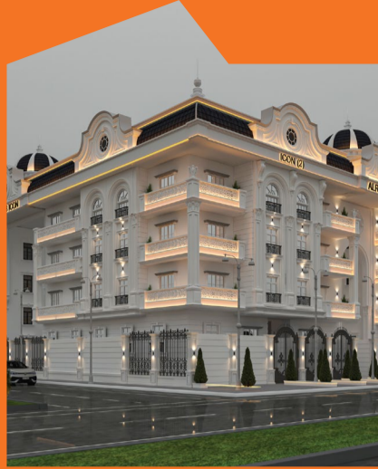
ALREHAB ICON شمال الرحاب القاهرة الجديدة
